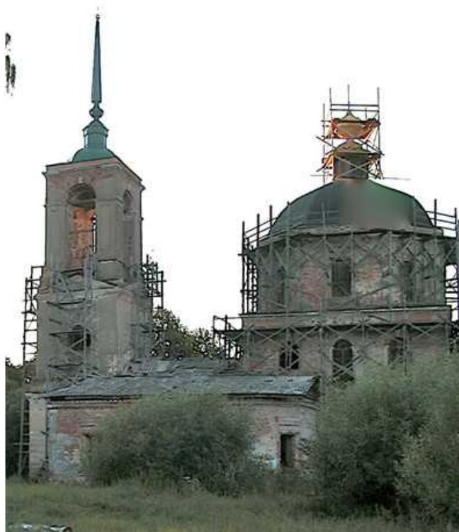
Никольская церковь во время работ (© Marion Garcia)
