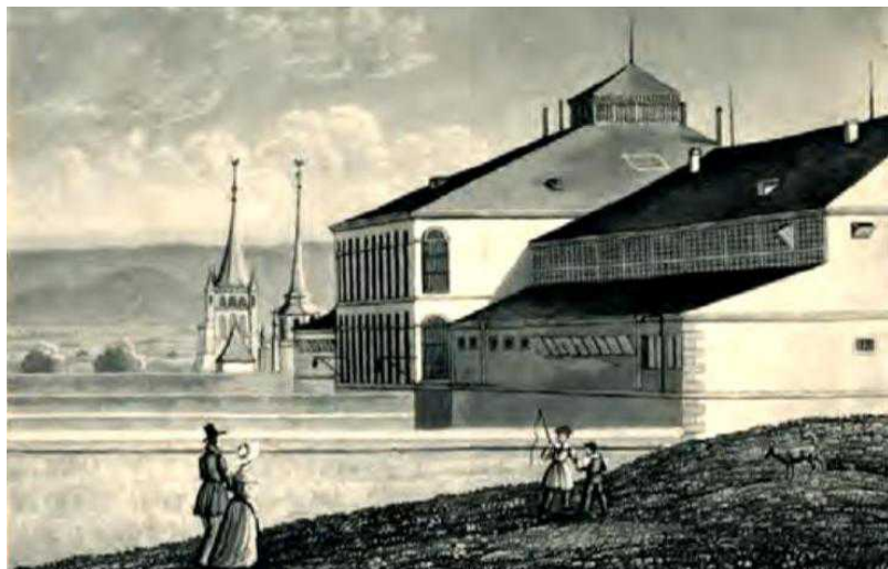
Исправительный дом Бетюзи, Лозанна, 1830 (lausanne.ch)
