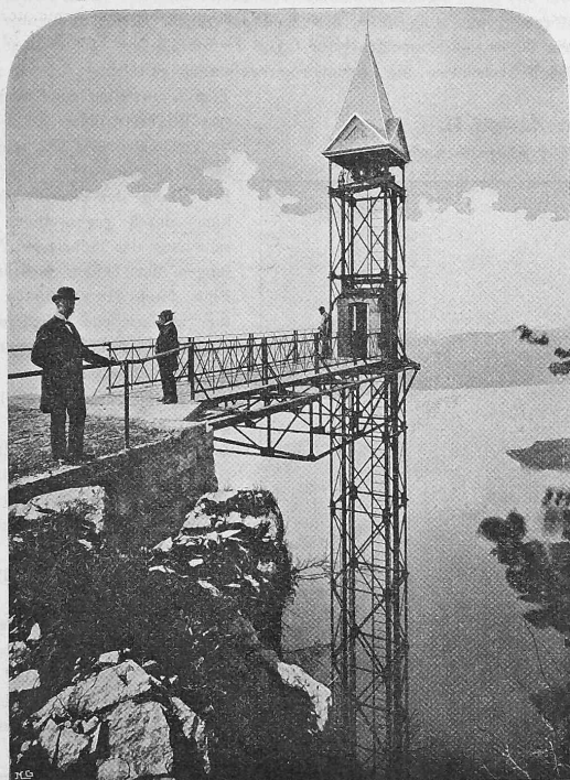
Abb. 3. Obere Plattform und Zugangsteg.
