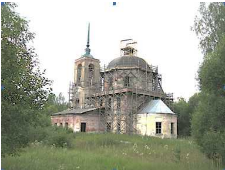
Никольская церковь в строительных лесах (©Marion Garcia)
