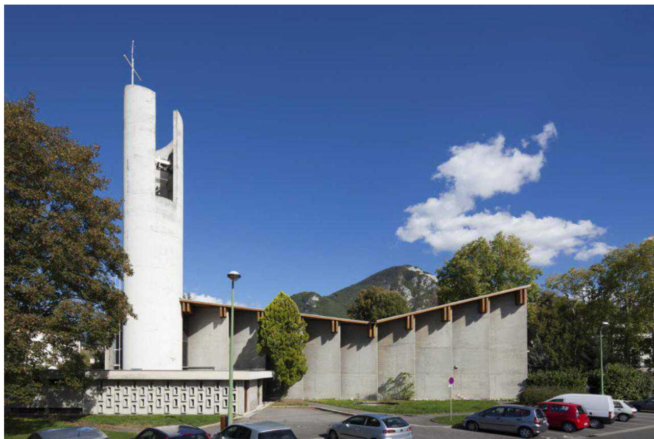
Церковь Св.Бернадетты - главная площадка Фестиваля
