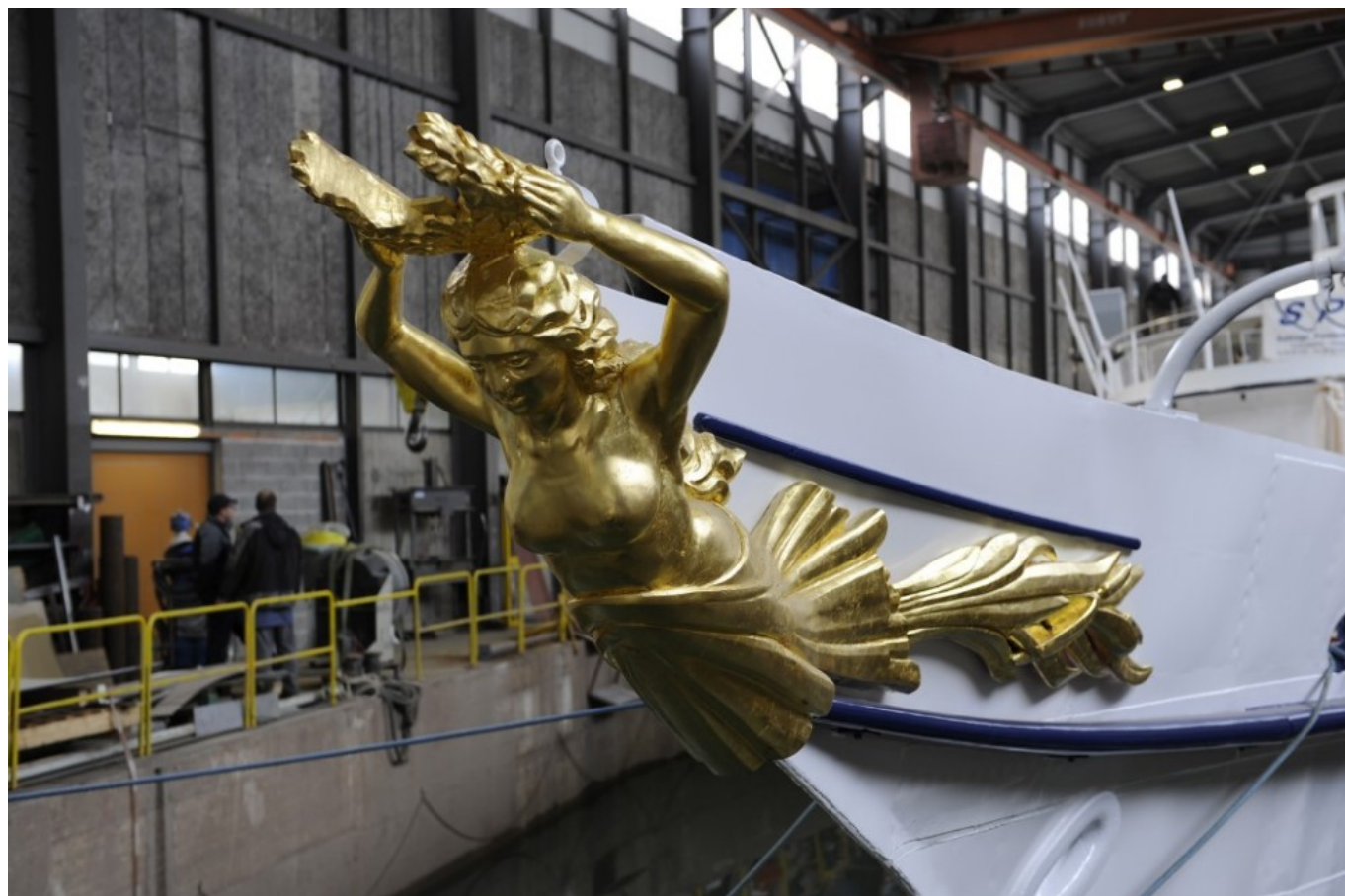
Ремонтные работы на пароходе «Suisse» (abvl.ch)
