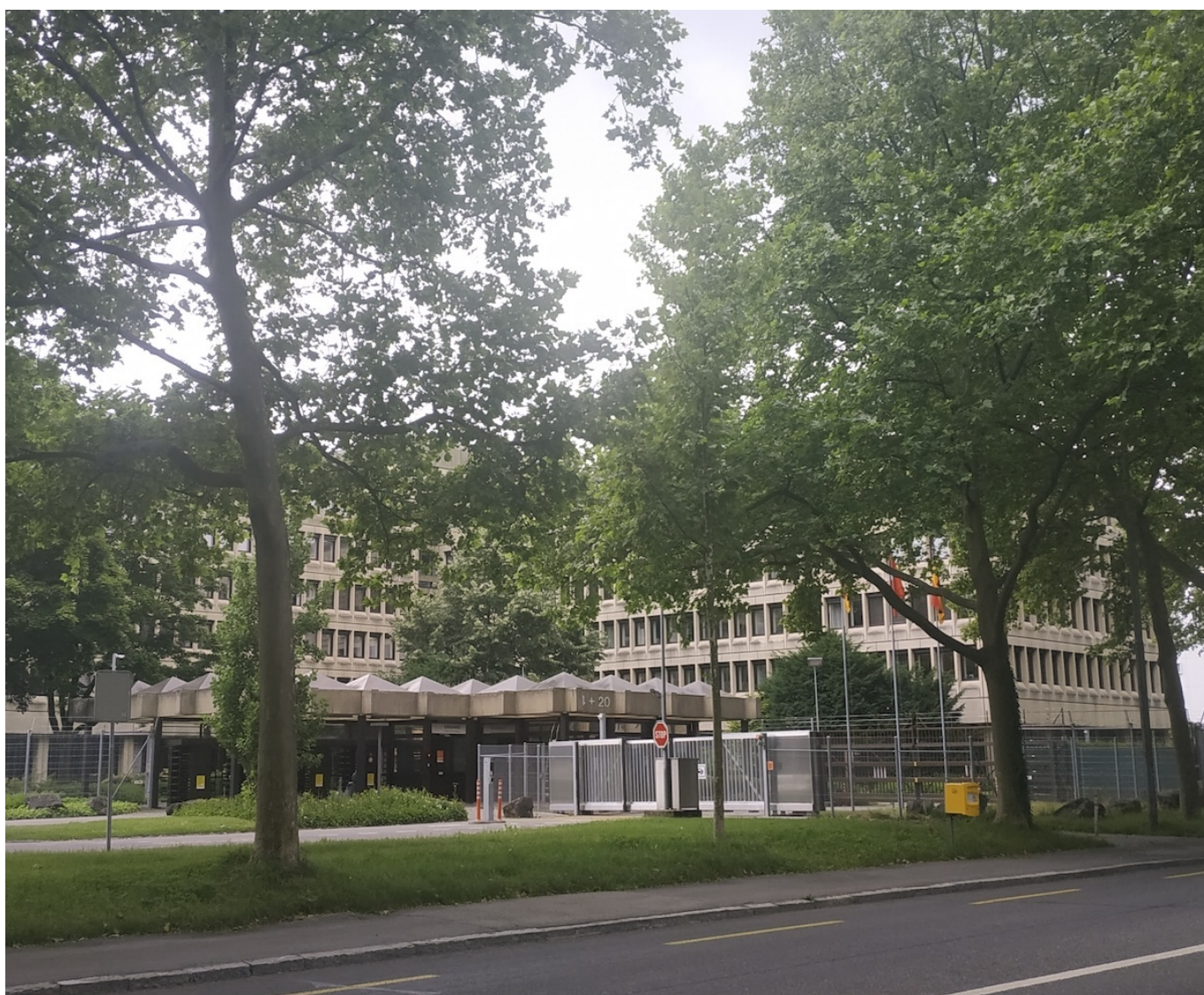
Здание SRC/NDB в Берне. Фото: Nashagazeta.ch
