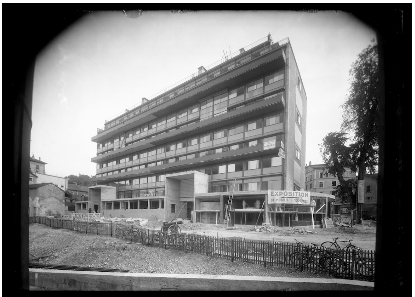
Ле Корбюзье, Пьер Жаннере. Строительство Clarté, 1931. Fonds Sigfried Giedion, GTA Archiv /ETH Zurich © F.L.C./2025 ProLitteris Zurich. Bibliothèque de Genève, photo: Frank-Henri Jullien
