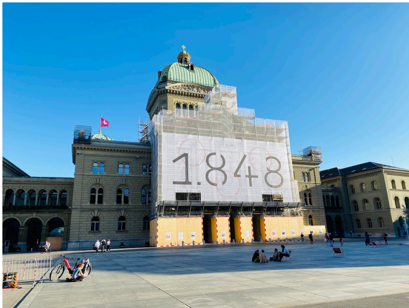
За строительными лесами скрывается мозаика «Тило». Фото: Nashagazeta.ch
